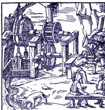
Abb. 544. Schöpfkolbenkette (Paternosterwerk), nach Agricola, 1556.
